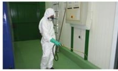
Aplicación de Biocidas DDD Revestimientos y otros
